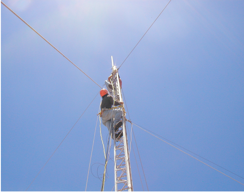
Figura 7.2: Una torre venteada escalable.
